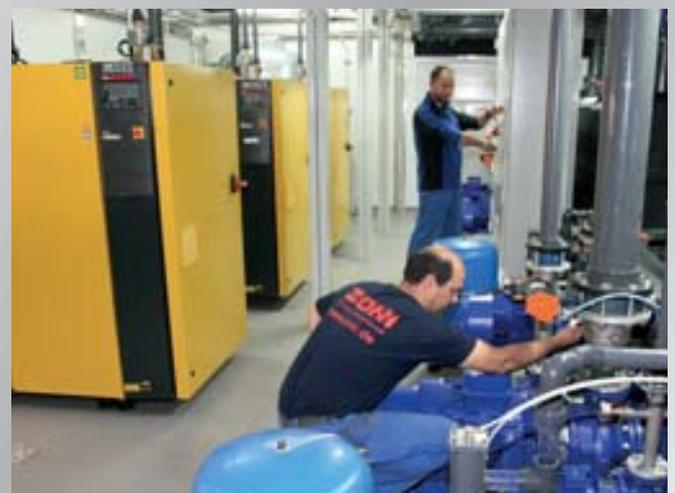
Großkompressorenanlage mit Wärmerückgewinnung
