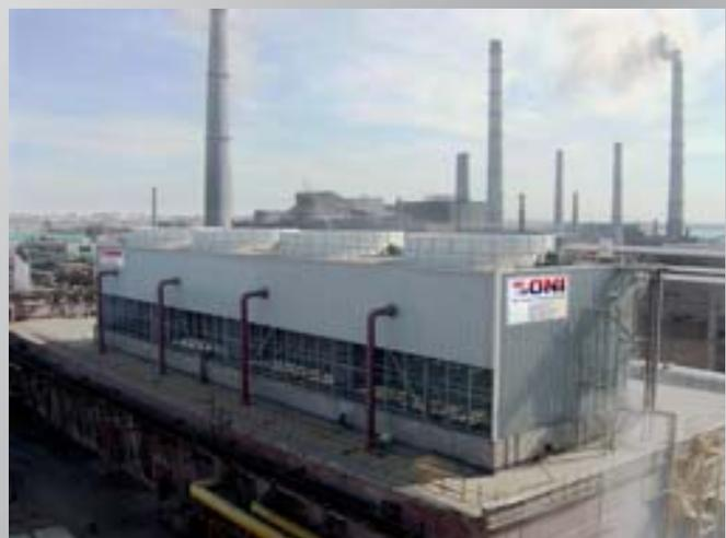
Großkühlanlage mit einer Leistung von 150.000 kW für einen Chemiebetrieb in Kasachstan in der Endmontagephase.
