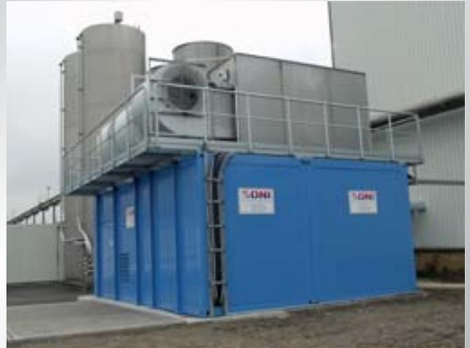
Container-Kühlanlage mit Zellenkühlturm und Systemtrennung über Wärmeaustauscher
