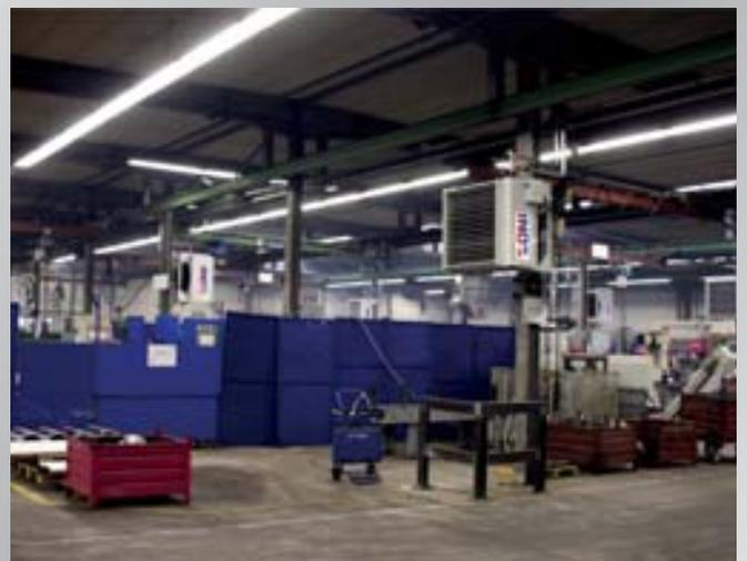
ONI-Heizgeräte in einem Produktionsbereich eines Metallverarbeiters, die mit kostenloser Abwärme aus dem Kühlprozess von Metallschmelzanlagen heizen.
