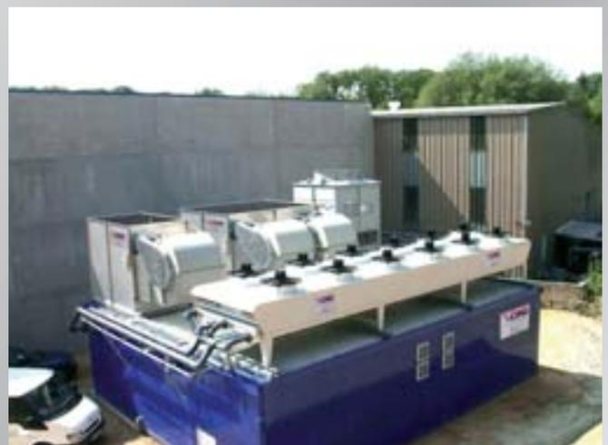
Modular aufgebaute Energiezentrale mit einem prozessangepassten Zweikreis-Rückkühlsystem.
